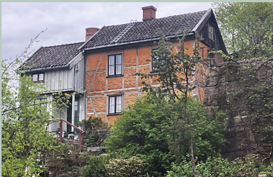
Akersbakken 14, Oslo. Et bindingsverkshus oppført ca. 1830 i én etasje, påbygget annen etasje 1849. Opprinnelig trappehus revet før 1970, nytt trappehus av bordkledd bindingsverk oppført 1975.
