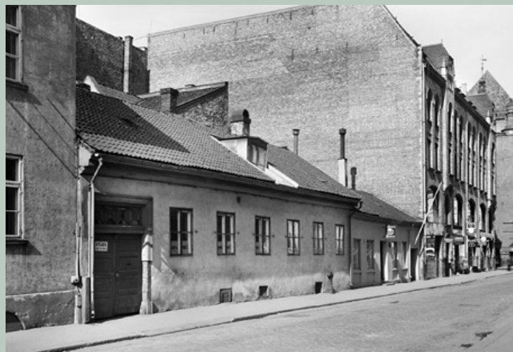
Fred. Olsens gate 13, laftehus fra ca. 1700, forblendet med murverk og puss rundt 1810 for å se ut som et murhus.
