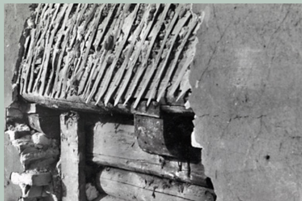
Detalj av etasjeskille under rivning i 1957–58. Lafteveggen i første etasje har rester av murforblending til venstre. Over denne litt av utkragende laftevegg i annen etasje med pussarmering av påspikrede kløyvde hasselkvister. Hensikten var å få hele fasaden i samme plan, som murhus oftest har.
