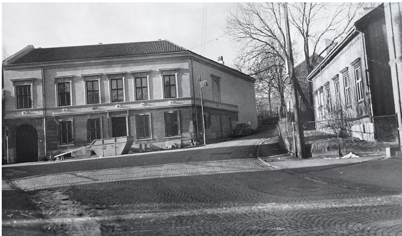
Renovering av Sagveien 28 i 1975.
