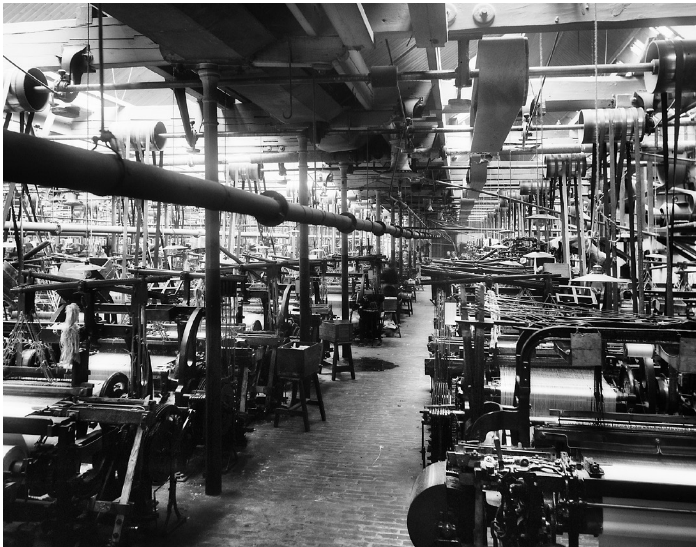
Hjula Veveri, 1910. I denne salen var det plass til 400 vevstoler. Hver vevstol ble drevet av en rem som kom ned fra en drivaksel oppunder taket. Risikoen for alvorlige skader var åpenbar.
