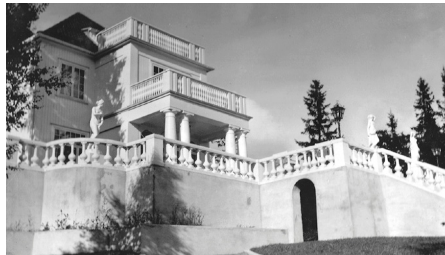
Villa Troldmyr, Voksenkollveien 5, etter utvidelse og ombygging i 1932. Under parkanlegget og hagen fantes flere underjordiske rom med vinkjeller, hvelv og kapellet med kopi av altertavlen fra Molde gamle kirke.
