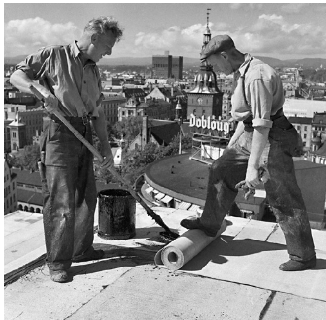
Taktekkere i arbeid på det kommende Hotel Viking, august 1950.
