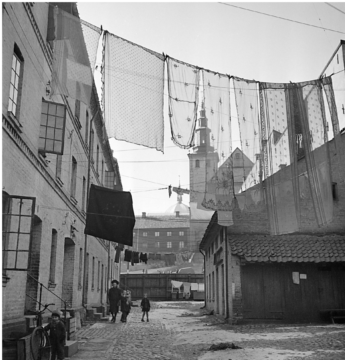
Gårdsrom i Nedre Hammersborggate, 1962.
