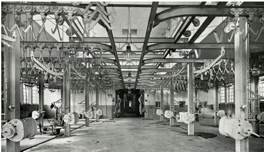
Slaktehallen for storfe sett mot forbindeshallen.
