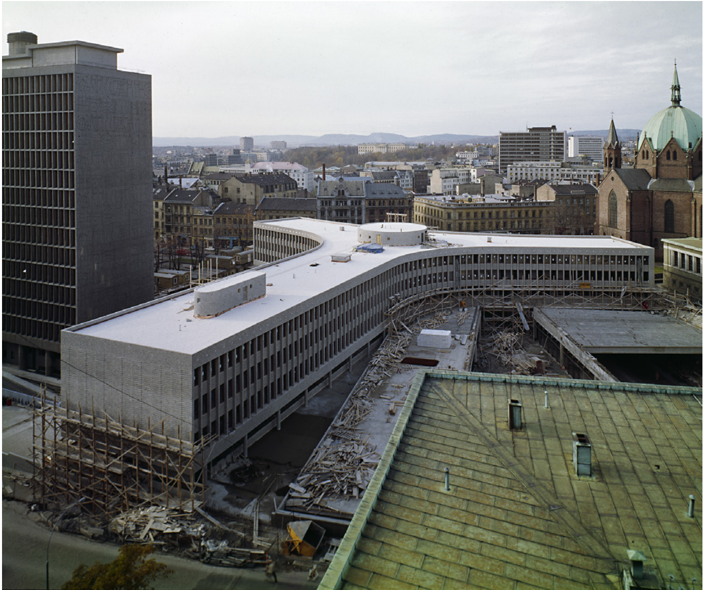
Y-blokka under oppføring, 1969.
