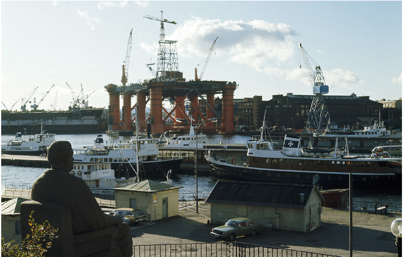
Oljeplattform under bygging på Nyland Vest (tidligere Akers mek. Verksted), høsten 1975.
