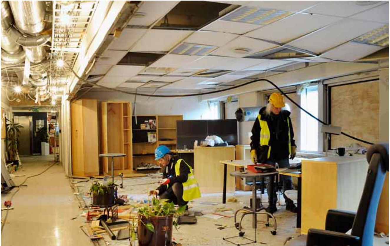
Fotodokumentasjon og innsamling av gjenstander inne i bygningen R4.
