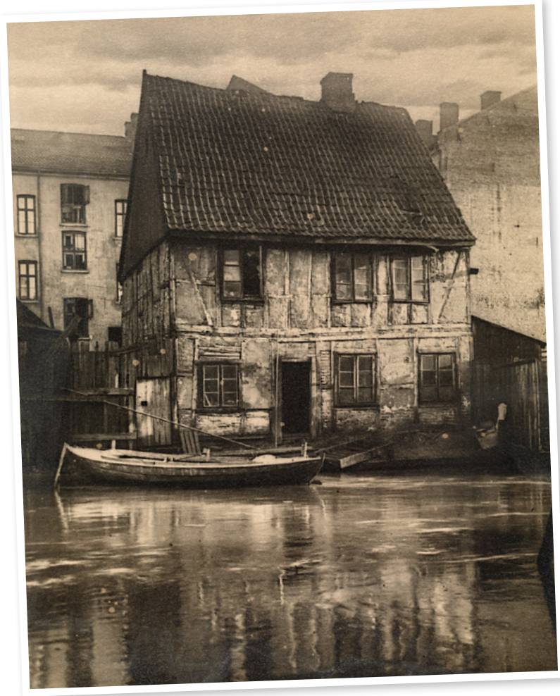
Bindingsverkshus i Breigata 2 ved Akerselva, ant. 1923. 275x220 mm på baryttpapir.
